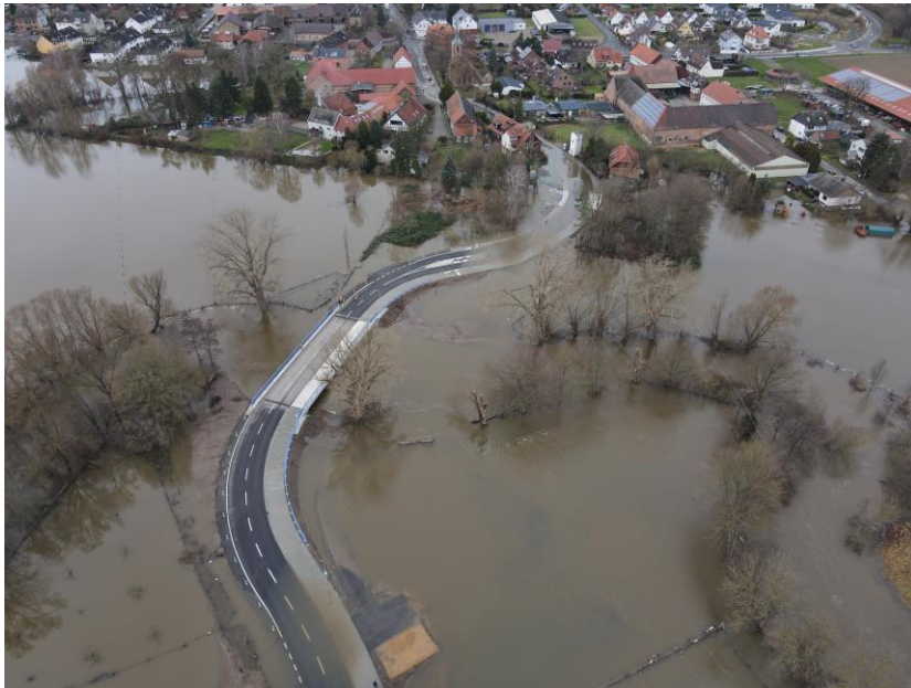
Abbildung 16: Überschwemmungen nach Dauerregen im Dezember 2023 in Leiferde an der Fischerbrücke (Malteser Braunschweig 2023)
