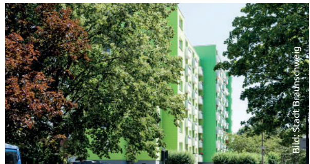
Neugestaltung der Fassaden Orlastraße
