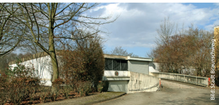
Ehemalige Garagenanlage Ecke Saale-/Elbestraße
