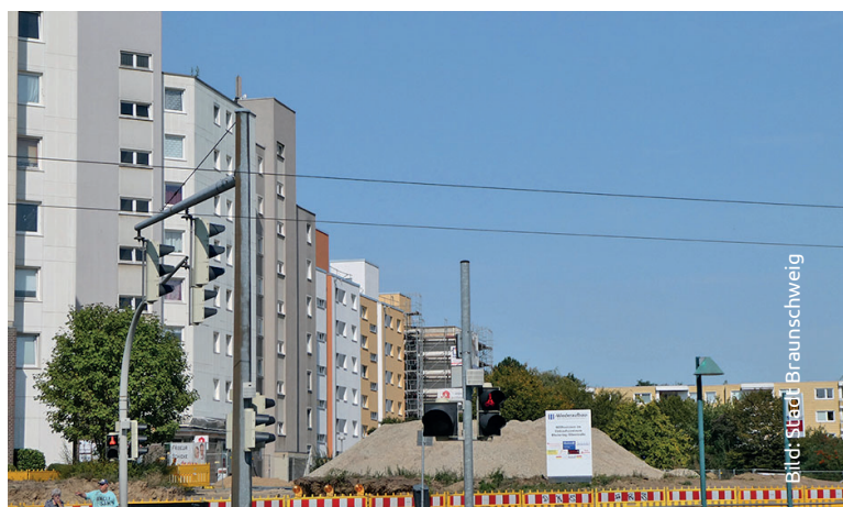
Baustelle des neuen Einkaufszentrums
