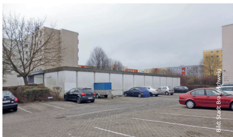
Garagenanlage Saalestraße 16a vor der Umsetzung
