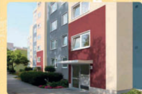
Eingänge Ilmweg Nr. 8, 10 und 12: Ein kräftiger Rotton steht für die Adresse „Ilmweg“
