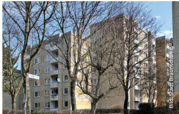
Gebäude Ilmweg 24-26 vor der Sanierung
