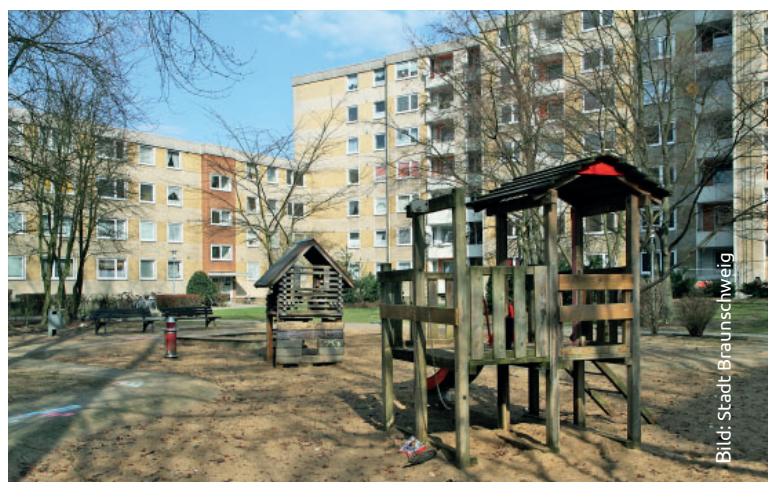
Mittelhof vor der Sanierung
